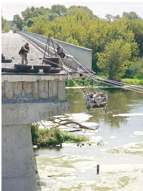
Фото 6. Застосування конструкції канатної переправи та нош корабельних для евакуації поранених, травмованих та хворих через водні перешкоди.
